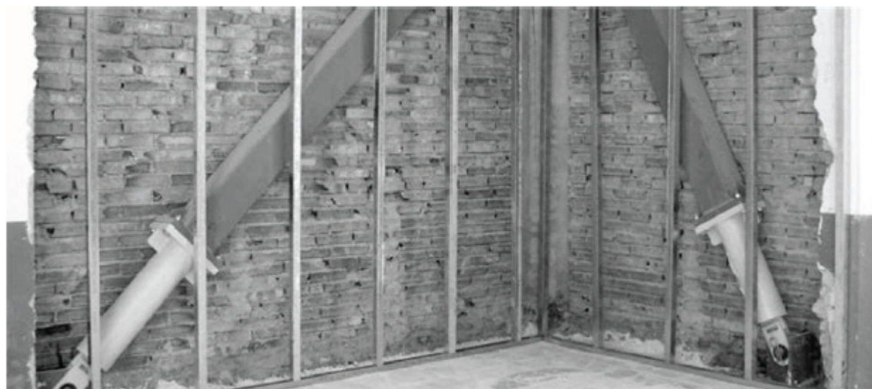
Consolidamento antisismico in un'abitazione
